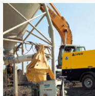
Proyección de hormigón
